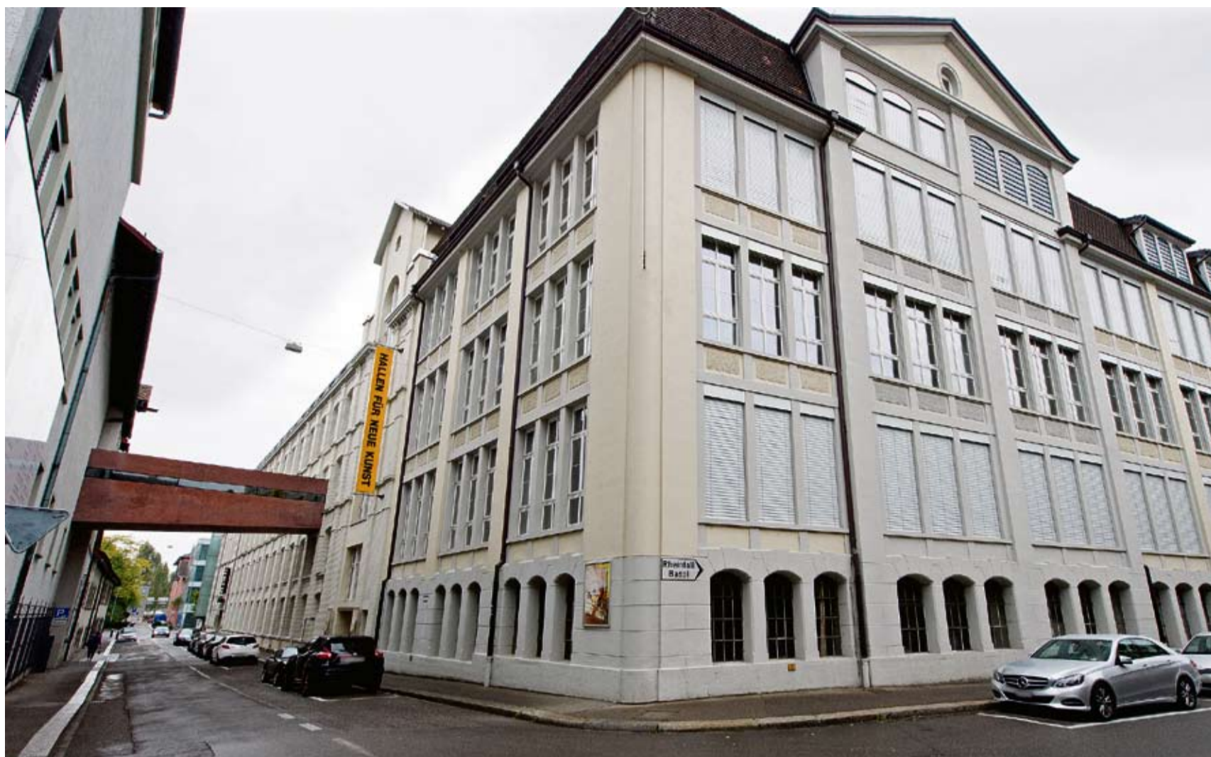
Die Stadt ist seit gestern wieder Hausherrin im Gebäudeflügel an der Baumgartenstrasse: Zur Begutachtung des «Kapitals Raum 1970–1977» brachten die Eigentümer gestern mehrere Beuys-Kenner mit. Damit das Werk auch zu sehen ist, wurden die bisher geschlossenen Jalousien im zweiten Stock aufgerollt. Bild Selwyn Hoffmann
